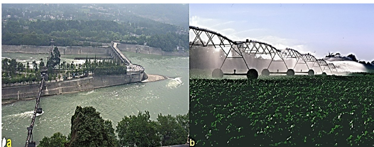
Figura 1 - (a) Estrutura (Dujiang Weir) para o sistema de irrigação e (b) Irrigação em uma fazenda de algodão.
