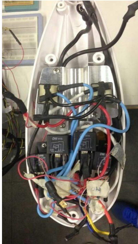
Figura 3. 2: Relés para Aacionamento do Propulsor.
